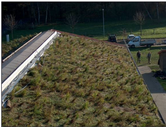
Sumpfpflanzendach der FAL in Braunschweig
