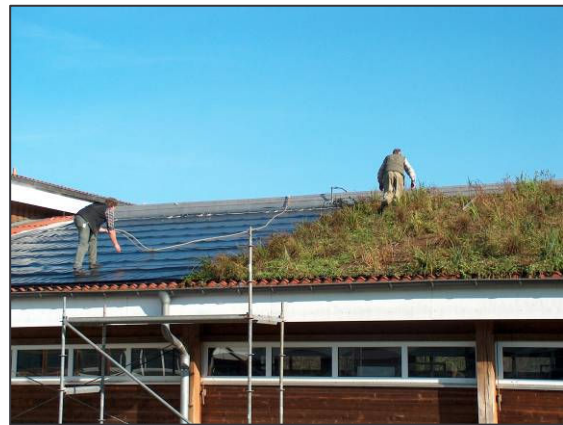
Aufbringen der Pflanzenmatten auf der FAL
