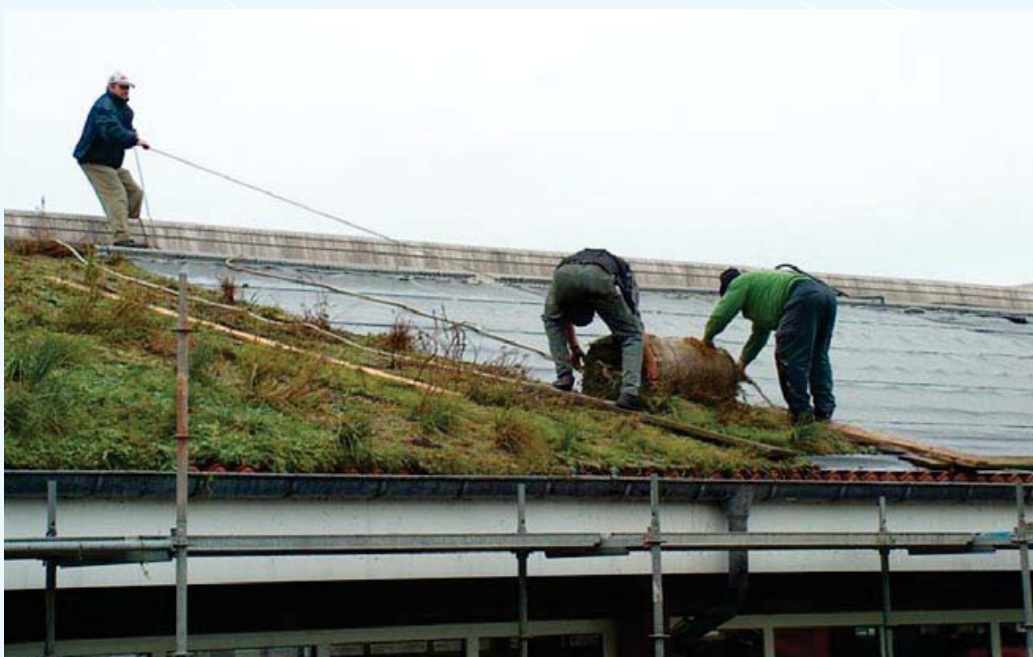
Installation der Pflanzenträgermatten (2005).
