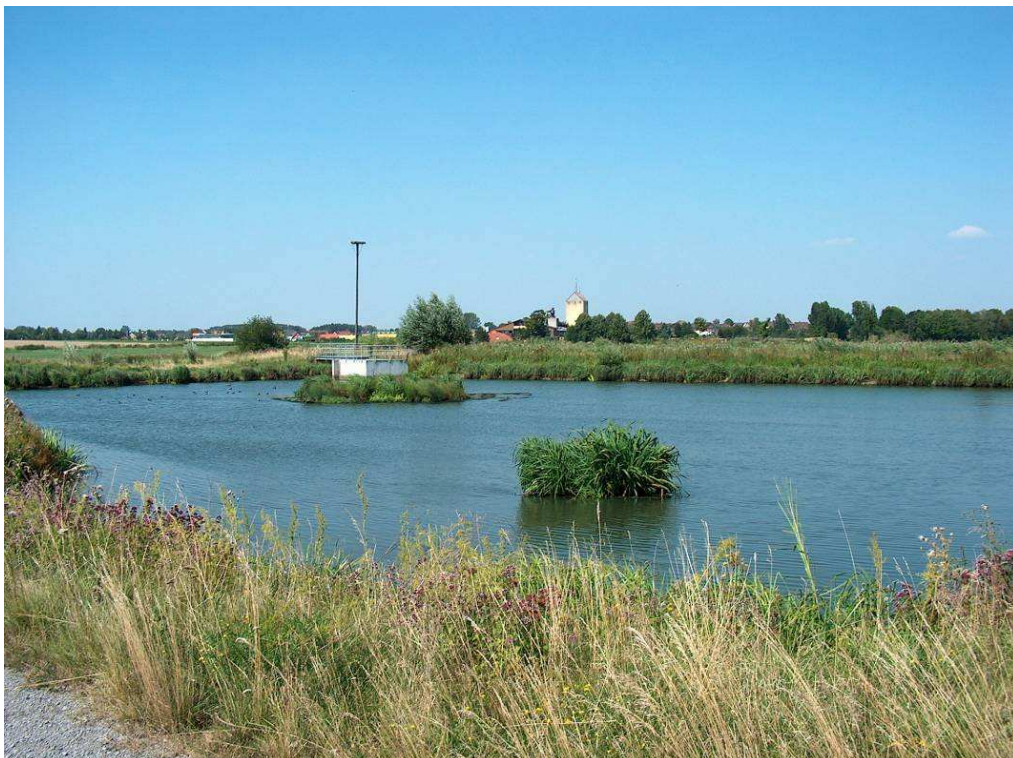
Teichinseln auf einem Speicherteich vor einem Retentionsbodenfilter (Mischwasserbiotop in Niedersachsen) (Foto Blumberg)
