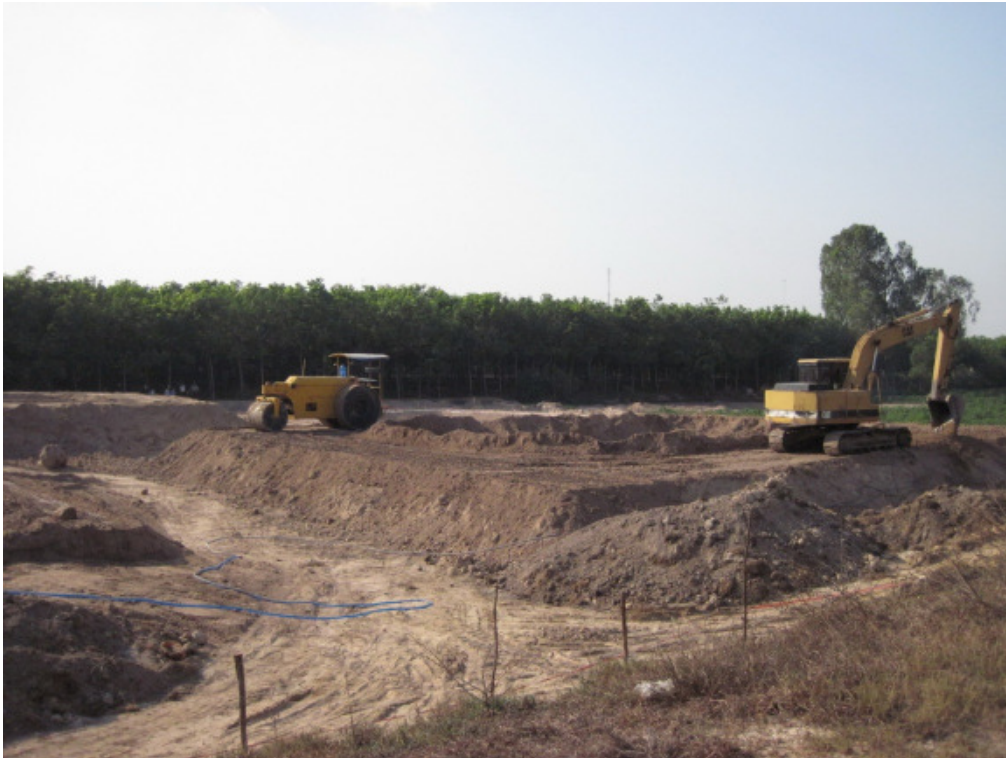
Baustelle Vietnam April 2010
