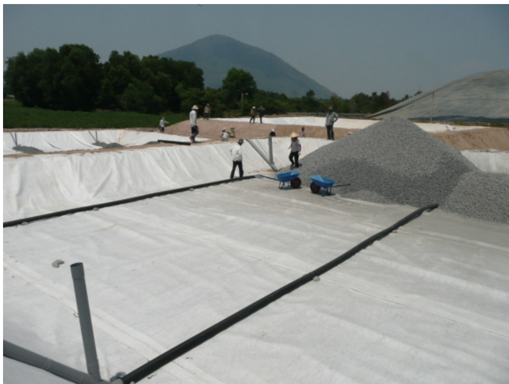
Baustelle Vietnam Juni 2010
